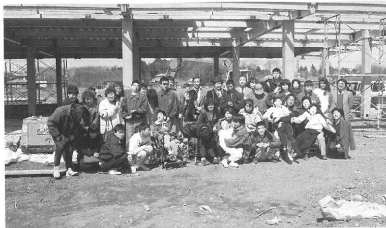
▲建設中の川越いもの子作業所でみんなと撮影
